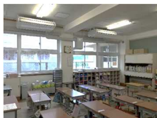
【空調設備・換気設備を備えた教室】
