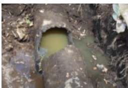
配管の腐食
