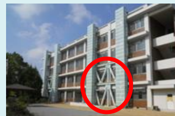
施設の耐震化(耐震ブレースを設置)
